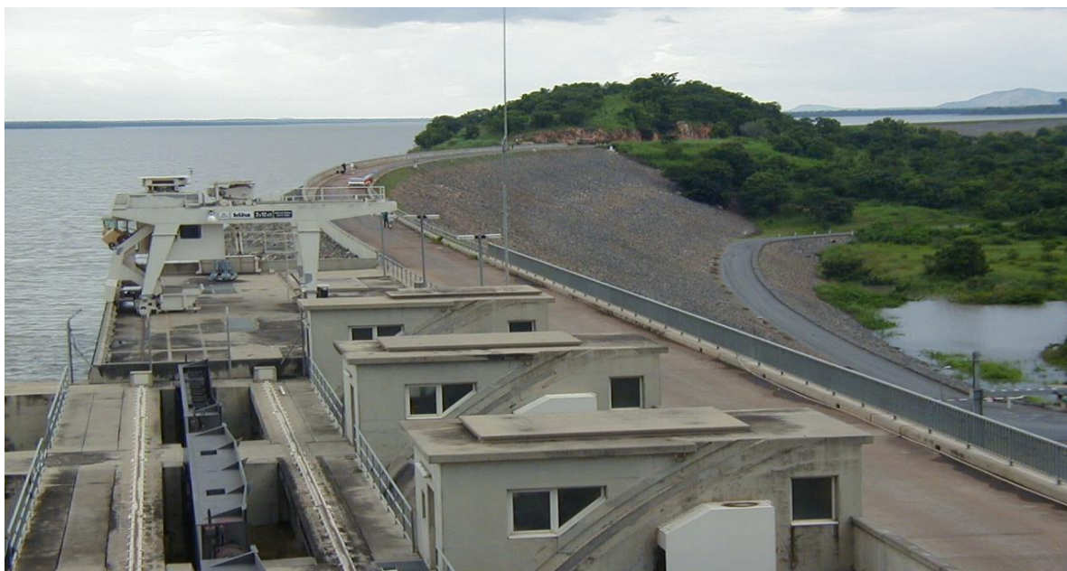
BARRAGE HYDROELECTRIQUE DE NANGBETO
